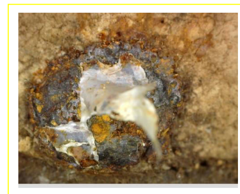
სურ. დეტალი. გვერდხედი. ჟანგიანი ლურსმნები და დანაკარგი
